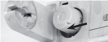
2. Trifft das bei Ihnen zu, können Sie ohne Umbau der Leuchte unsere Jamara-LED-Leuchtröhren 1 zu 1 tauschen. Alte Leuchtstoffröhre inklusive Starter (durch drehen) raus nehmen und die neue Jamara-LED-Leuchtröhre einsetzen.
